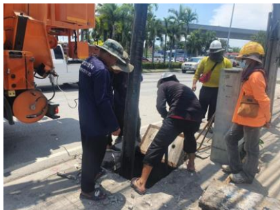
รูปที่ 26 การขุดลอกทรายระบายน้ำบริเวณหน้าโครงการ
