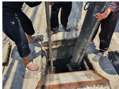
รูปที่ 26 การขุดลอกทรายระบายน้ำบริเวณหน้าโครงการ
