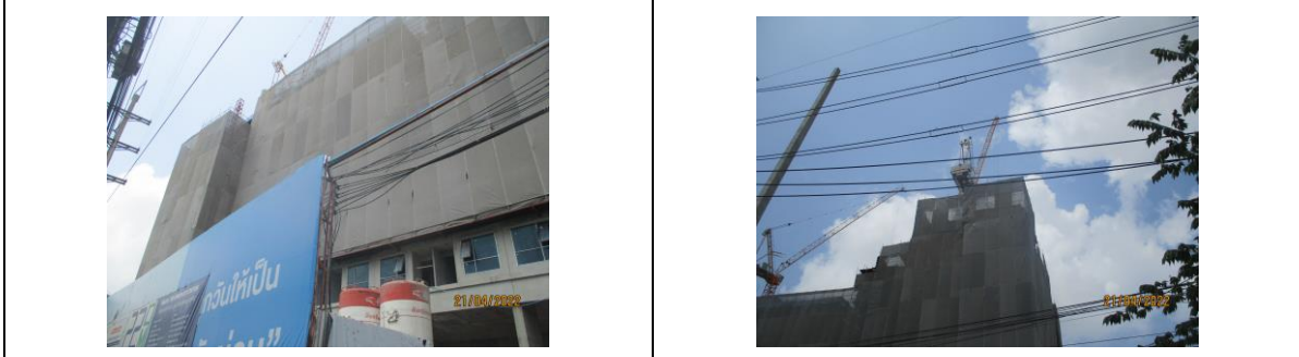
รูปที่ 10 ติดตั้ง Mesh sheet
